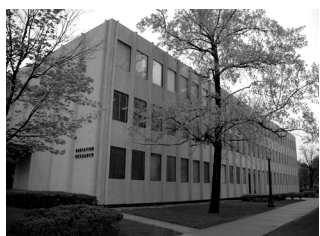
A research powerhouse ...pages 4-5
